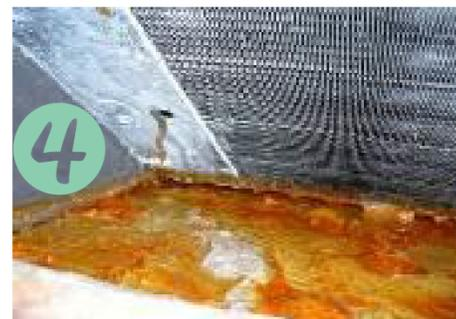
**Les filtres (1)** laissent passer la micro poussière qui vient se coller sur l'avant de **la batterie (2)** et passe à travers en colmatant l'arrière de la batterie tout en se collant sur **la turbine (3)**.
