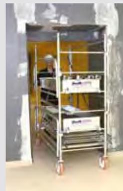
L'AC SE DÉPLACE TRÈS FACILEMENT SUR LE CHANTIER EN POSITION CHARIOT. PASSAGE DES PORTES DE 0,83 M.
